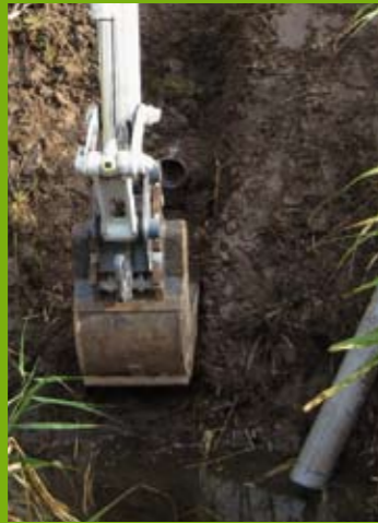
Graaf een sleuf
